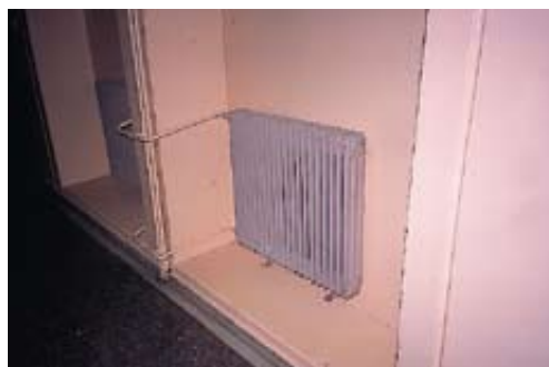
Καλοριφέρ σε εσοχή προφυλάσσει από ατυχήματα (Θεσσαλονίκη 2005).
