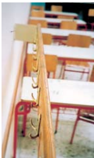
Προστασία από τραυματισμούς στους γάντζους ανάρτησης ρουχισμού με την τοποθέτηση εσωτερικά της δοκού (Θεσσαλονίκη 2005).
