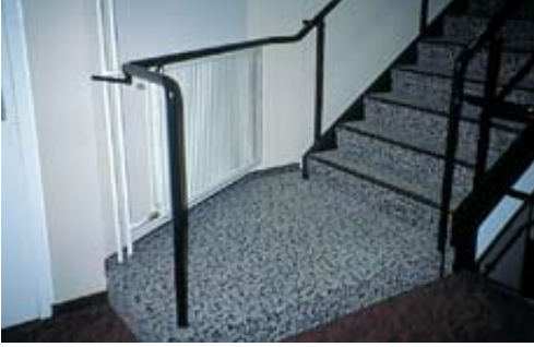
Υποδειγματική χειρολαβή, σε όλη την πορεία προς την σκάλα σε αίθουσα συνεδρίου στις Βρυξέλες.
