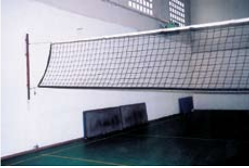
Ακατάλληλη ανάρτηση δικτύου βόλεϊ (Θεσσαλονίκη 2005). Όρια γηπέδου πολύ κοντά στον τοίχο.
