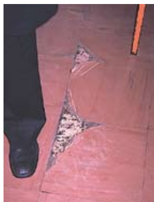
Ανασηκωμένα πλαστικά πλακάκια είναι συχνή αιτία πτώσης (Θεσσαλονίκη 2005).
