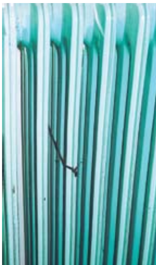
Πρόχειρη και επικίνδυνη συγκράτηση σώματος καλοριφέρ (Θεσσαλονίκη 2005).
