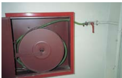
Πολύ μικρής διαμέτρου παροχή νερού για πυρόσβεση.
