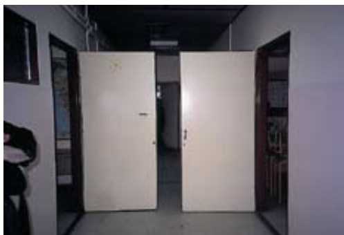
Οι πόρτες τάξεων δεν πρέπει να είναι ακριβώς απέναντι και δεν πρέπει να διασταυρώνονται (Θεσσαλονίκη 2005).
