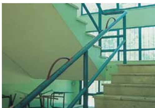
Κατάλληλη μέθοδος παρεμπόδισης τσουλήθρας (τα εμπόδια ίσως πιο κοντά και περισσότερα - Πάτρα 2002).
