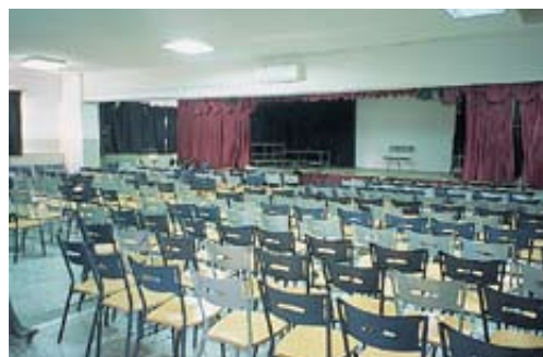
Λίγο αόριστο το καθεστώς προδιαγραφών για αίθουσες πολλαπλών χρήσεων. Συνήθως, δεν υπάρχουν τουλάχιστον αρκετοί πυροσβεστήρες, δεν υπάρχουν πινακίδες εξόδου και δεν υπάρχει πάντα δυνατότητα ταχείας εκκένωσης της αίθουσας.
