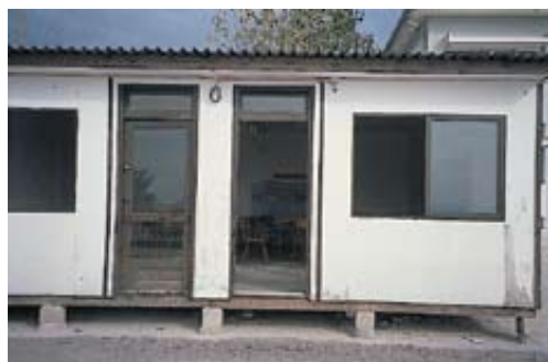
Προκατασκευασμένες τάξεις, συνήθως δεν πληρούν προϋποθέσεις ασφαλείας.
